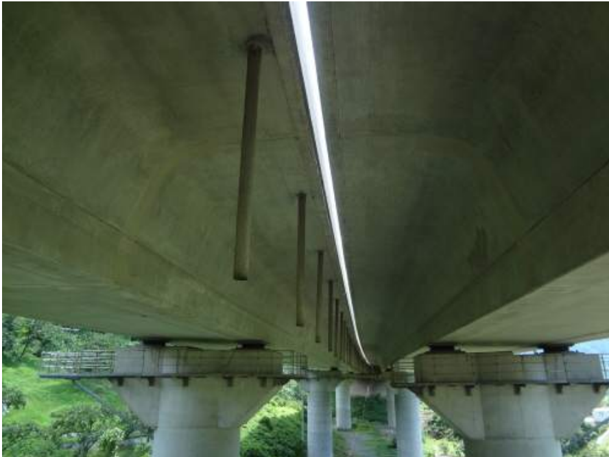
거더 외부 전경
