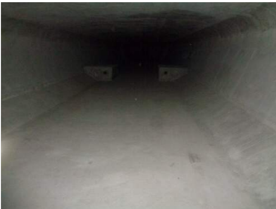
거더 내부 전경
